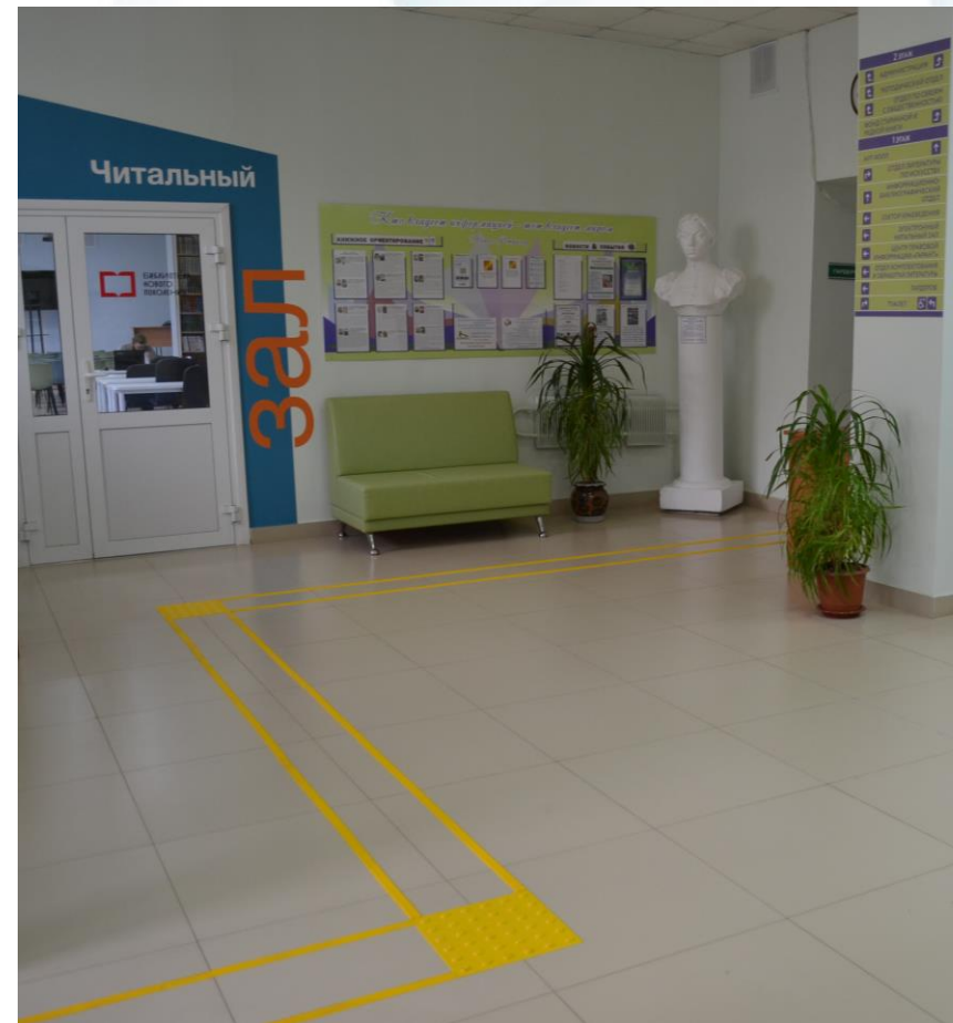
нанесение тактильно-визуальной разметки
