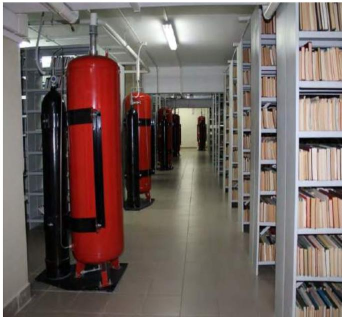
В 2016 году продолжилась работа по оборудованию системой автоматического пожаротушения помещений книгохранения старого корпуса библиотеки.
